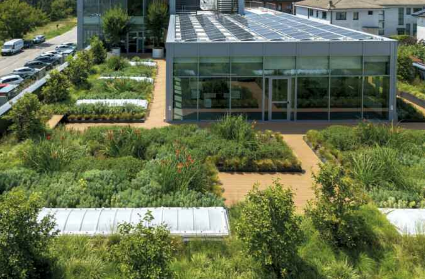
In alto: il roof garden e il volume vetrato degli uffici al primo piano. In questa immagine: l'aiuola centrale di erbacee perenni con fioriture rosse e arancioni.
